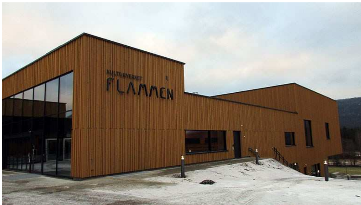
Bilde 1: Kulturverket Flammen ble overlevert januar 2017
