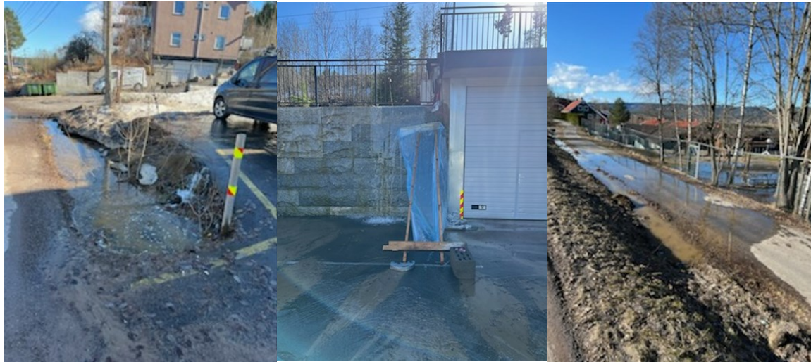
Bilde 1: Sett fra venstre: oppsamling av overvann i grøft, overvann rennende gjennom jernbanefylling og over støttemur, overvannsproblematikk fra Røde Kors-huset ned og over til Varingskollen Barnehage AS
